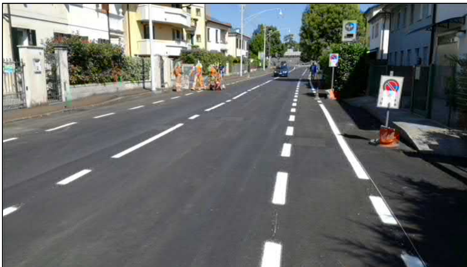
Tracciamento di una corsia ciclabile (Padova)
