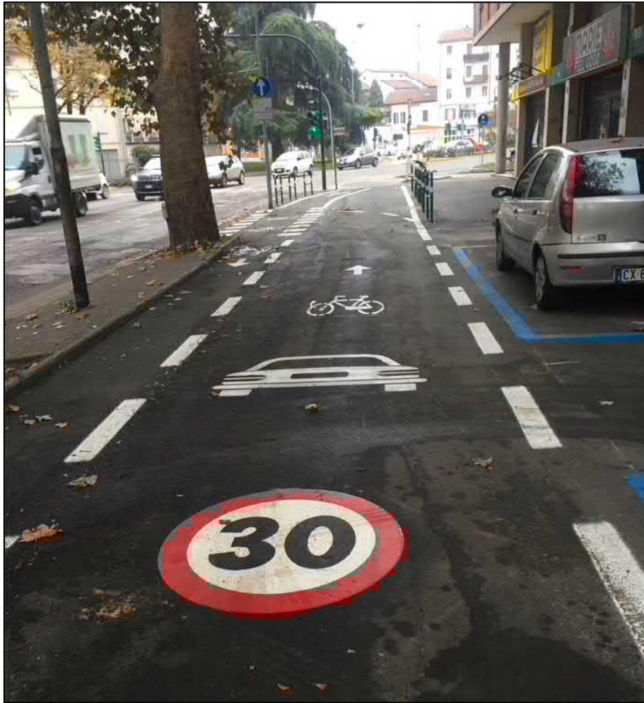
Esempio di applicazione integrata di alcuni dei nuovi dispositivi: strada ciclabile con doppio senso ciclabile (Reggio Emilia)
